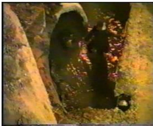
شکل ( ۲-۲۶) ریزش سقف کلکتور اصلی
