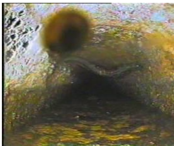
شکل ( ۲-۳۳) جدای و اشرف آب بند و تشکیل مانع
