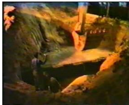
شکل (۲-۲۵) عملیات بازسازی کلکتور
