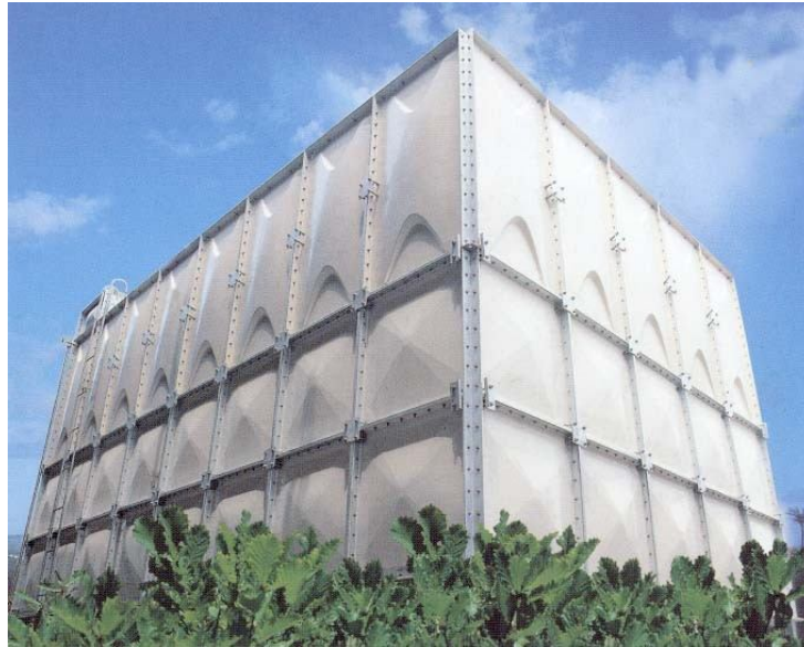
شکل ۶- مخازن سطحی قابل پیاده سازی سریع و مقاوم در برابر خوردگی و بعضی عوامل محیطی
